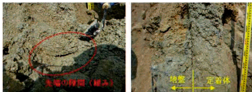
写真 4-12 引抜き後の定着体周辺の地盤状況(Case10)
