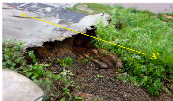
写真 2-9 応急復旧箇所と無対策箇所との境界
