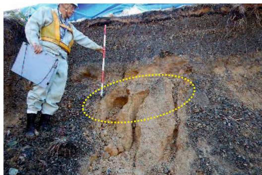
写真 2-5 崩壊直後の湧水状況
