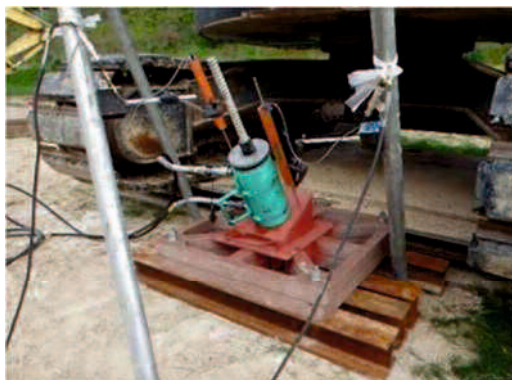
写真 4-6 引抜き試験状況
