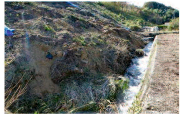
写真 2-3 のり尻部の河川への押し出し
