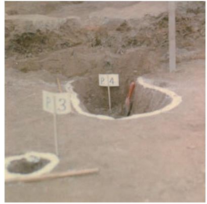
写真 226 Pit3・4 (南西から)
