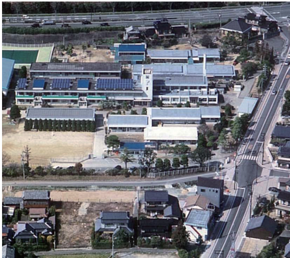
写真 185 調査地点遠景 (南上空から)
