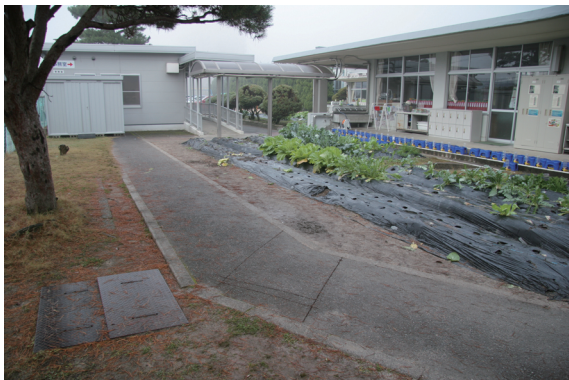
写真 186 調査地点近景 (東から)
