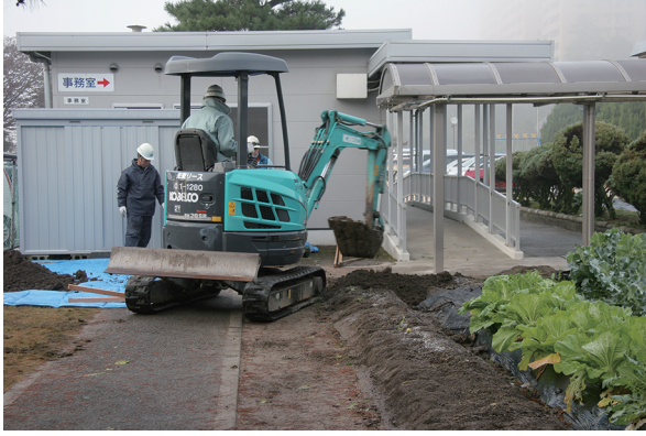
写真 187 重機掘削風景 (東から)
