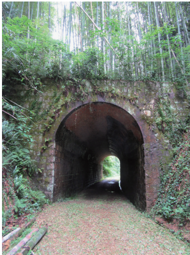
図8 旧吉部小学校の裏山にある旧船木鉄道のために作られた大桐トンネル、レンガでできている。船木鉄道開通期間 大正15年11月—昭和19年3月
