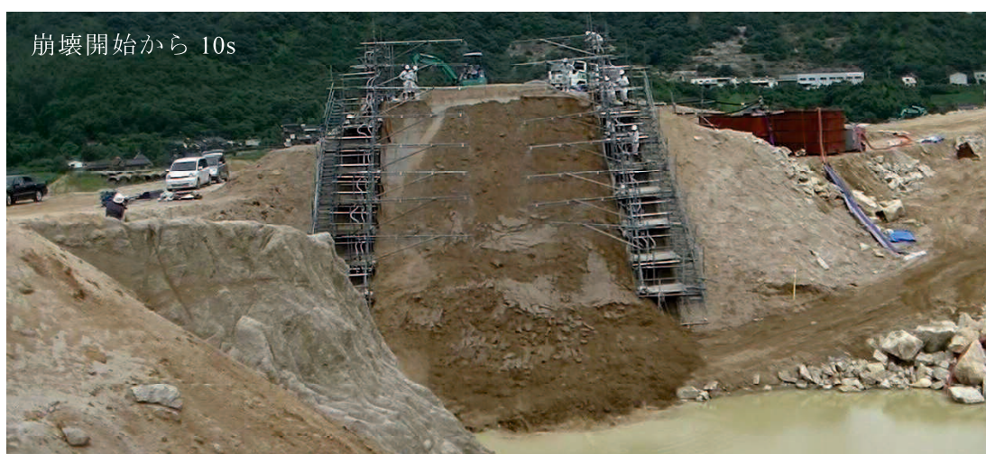
写真-5.4 実験2（裸地）の崩壊状況（その2）
