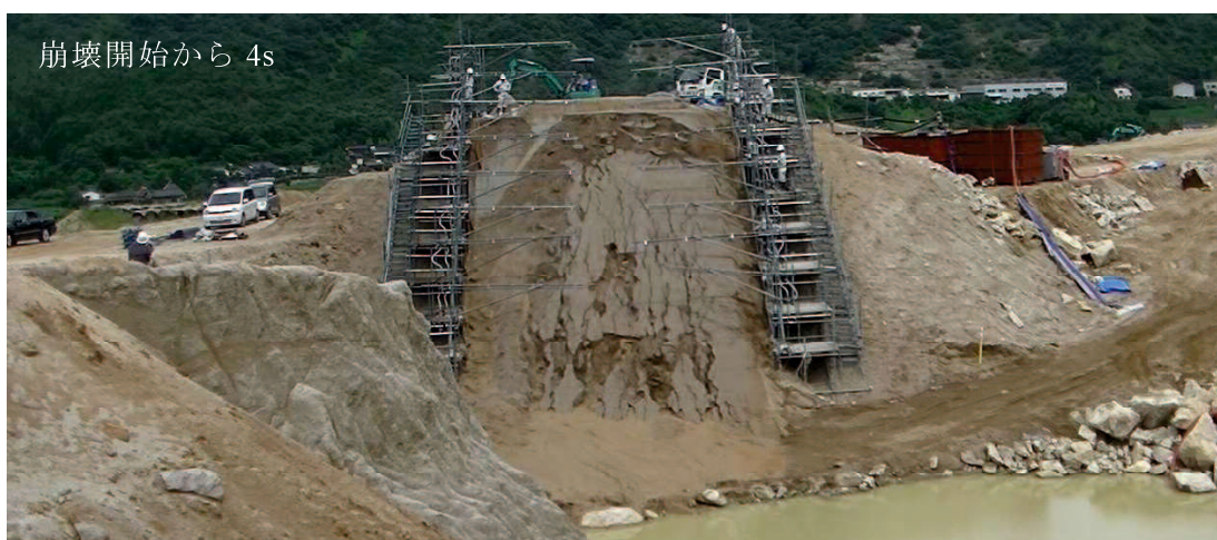
写真-5.4 実験2（裸地）の崩壊状況（その1）
