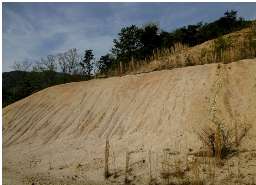
写真-3.3 試験施工法面の状況
