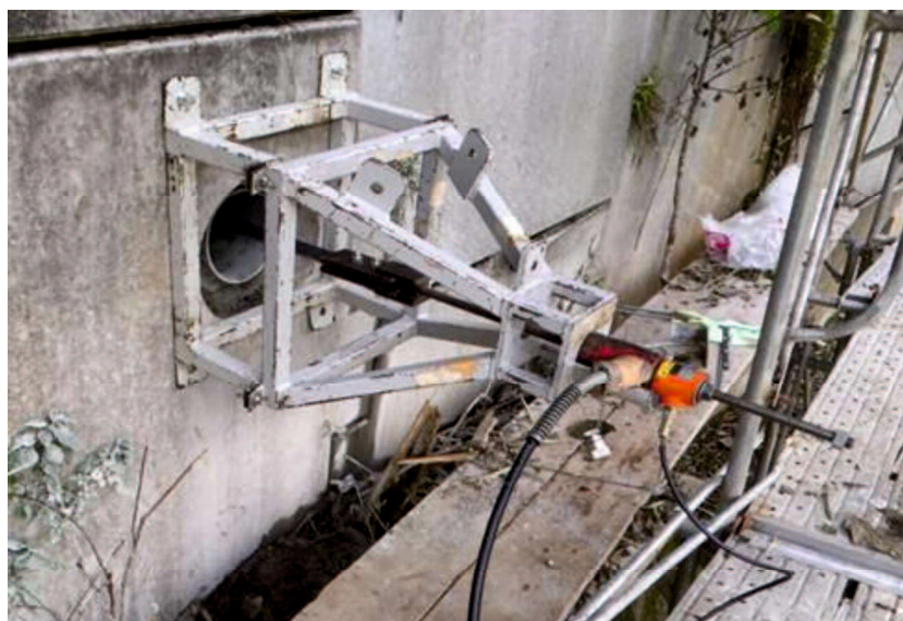
写真-5.4.2 健全度調査（コア抜きによる現場引抜き試験状況）
