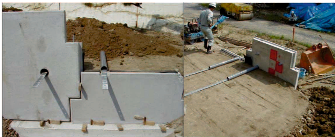
写真-2.4.3 試験盛土による現場引抜き試験状況
