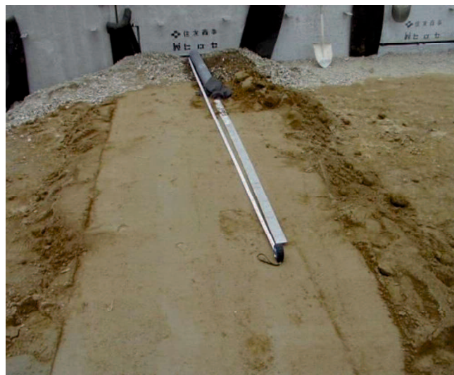
写真-2.4.2 現場引抜き試験用試験片設置状況 (壁背面 盛土側)
