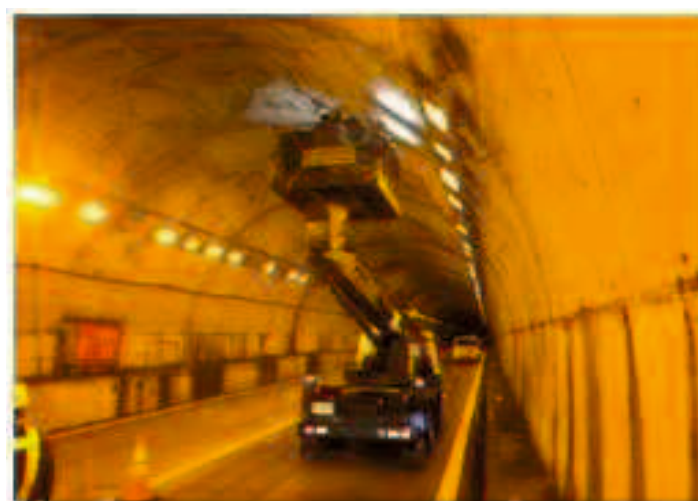
図-3.4 通常近接目視による点検
