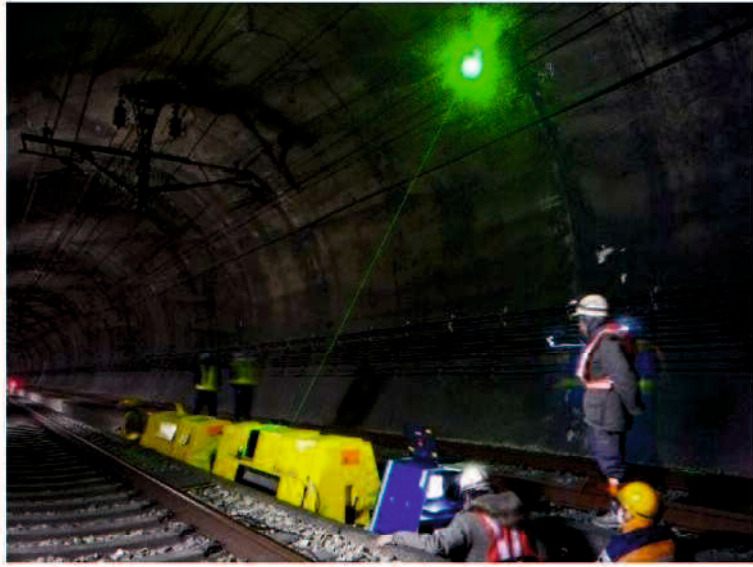
図-2.9 トンネル内での試験状況 21)
