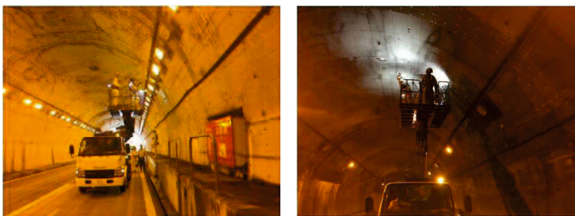
図-2.1 トンネル点検の状況
