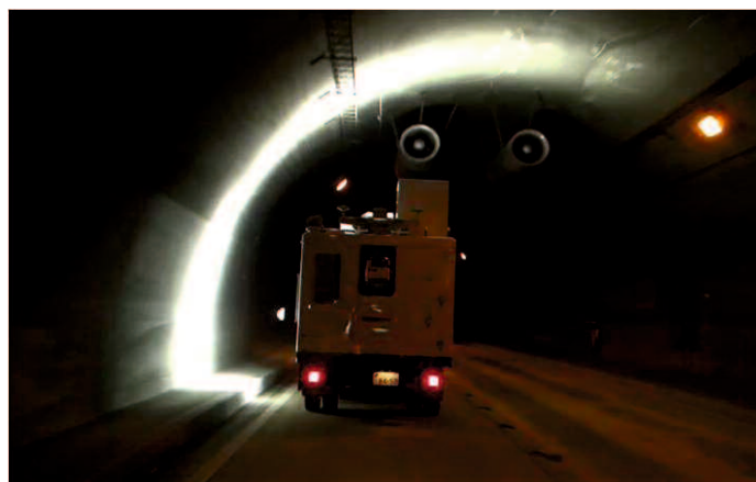
図-3.3 走行型覆工表面画像撮影技術による点検
