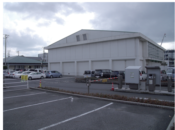
写真108 調査地点近景(北から)
