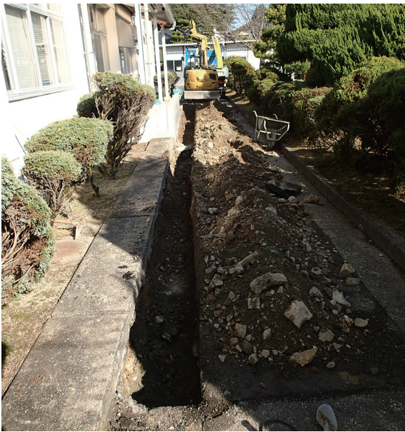
写真 105 調査区全景 (南西から)
