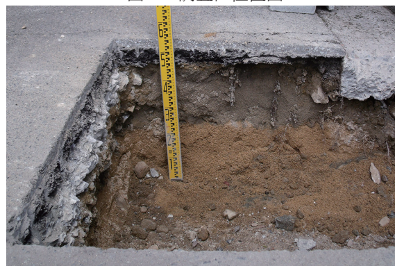
写真 84 A地点土層断面(西から)
