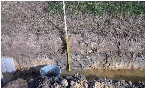
写真 87 B地点土層断面 (南から)
