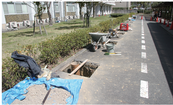
写真89 工事風景 (南西から)
