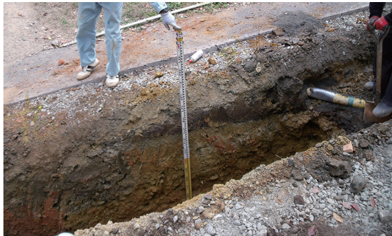
写真 48 A地点土層断面(南から)
