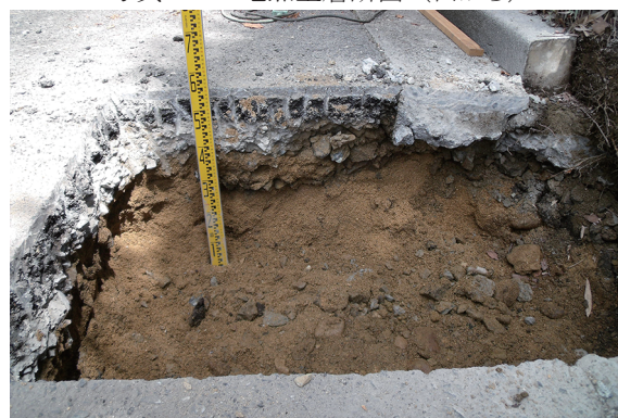
写真 85 B地点土層断面(西から)
