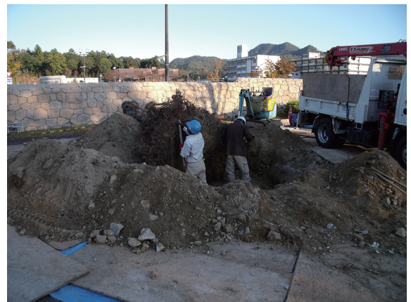
写真 99 工事風景（北西から）
