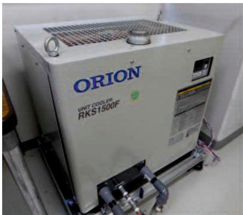
図 5.21 選定した冷却用チラー
