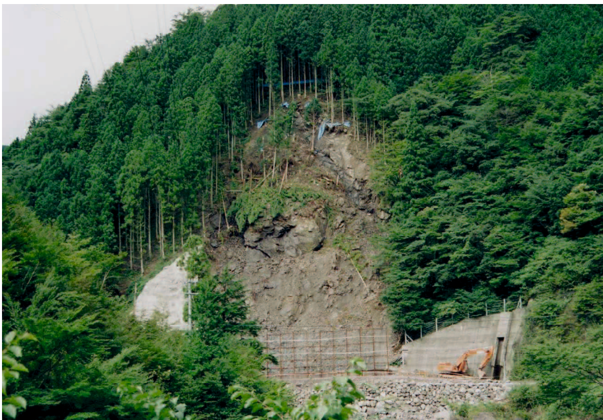
写真 5-10 徳島県 S 地区 全面崩壊直前の全景写真
