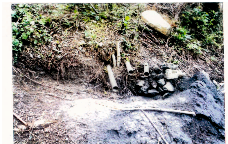
写真 4-1 徳島県 S 地区で施工された横ボーリング工
