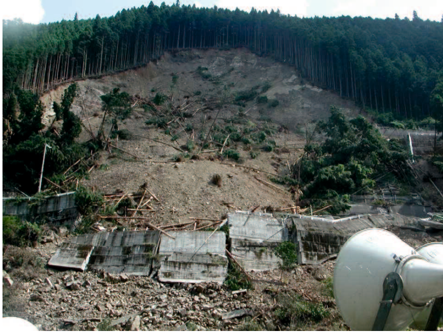
写真 5-8 奈良県大塔地区深層崩壊箇所全景
