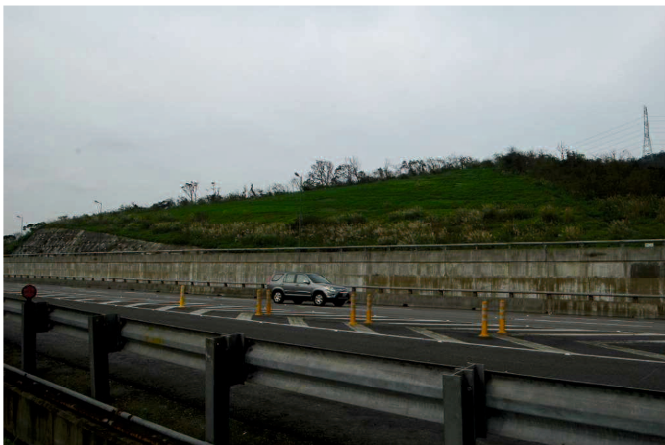
写真3-7 復旧後の国道3号、すべり面は種子吹付工で覆われている。
