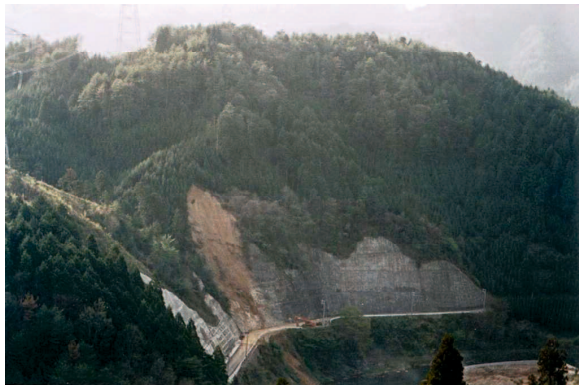
写真5-2 岩盤クリープブロック左側方部の崩壊状況
