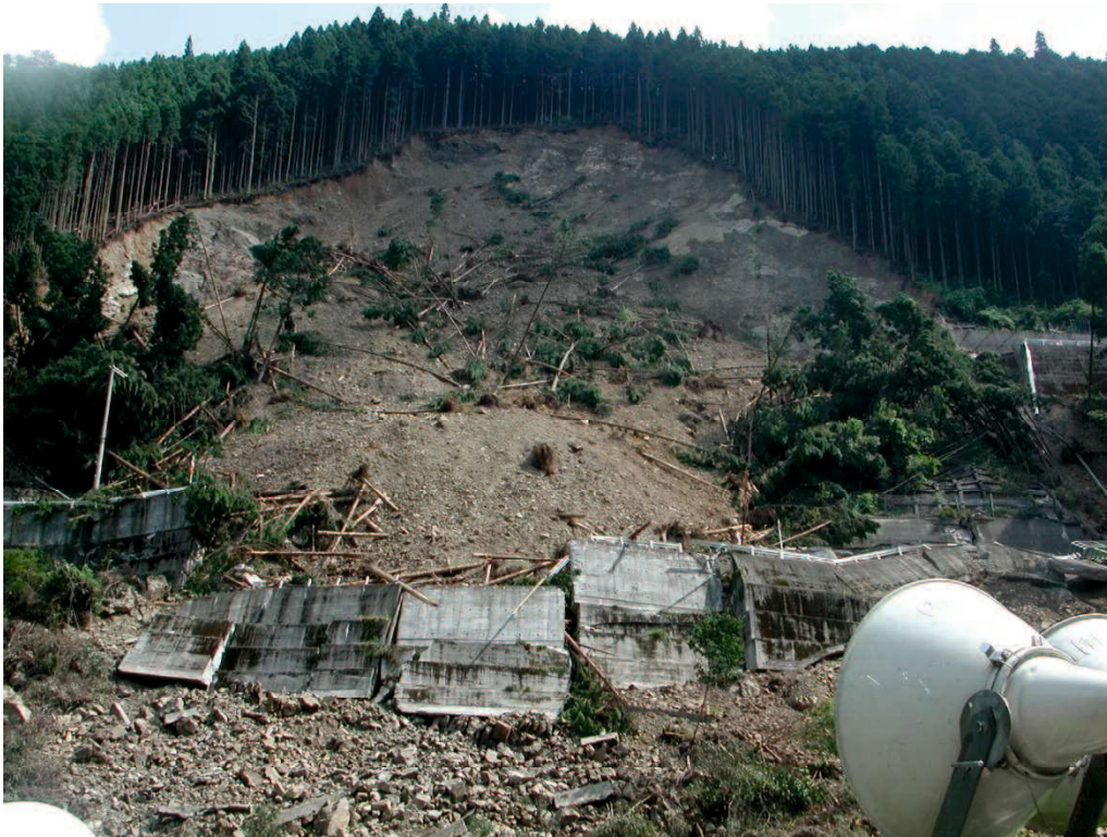
写真 3-3 2004 年 8 月 10 日 国道 168 号 奈良県大塔町（旧）において発生した深層崩壊
