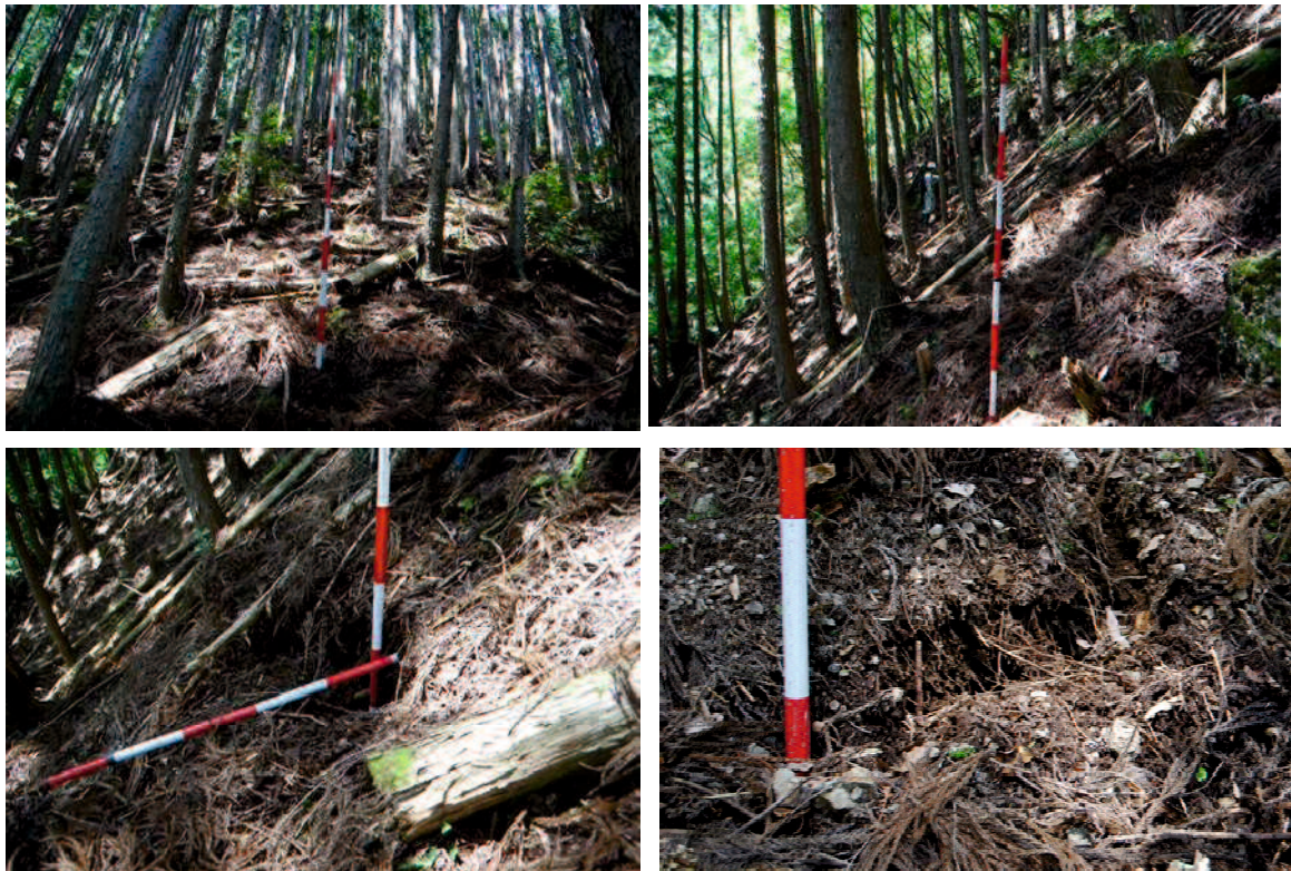
写真 5-13 冠頭部に形成された開口段差亀裂
