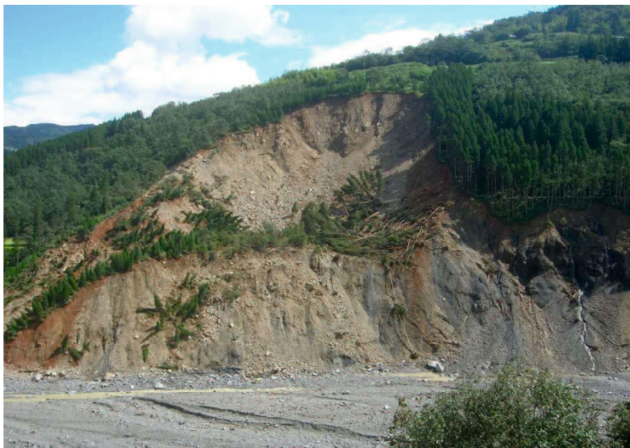
写真 3-2 2005 年 9 月 6 日 宮崎県美郷町島戸地区 台風 14 号の深層崩壊箇所
