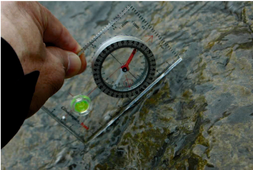
写真 3-5 九份二山の深層崩壊 侵食されたすべり面跡の露頭
