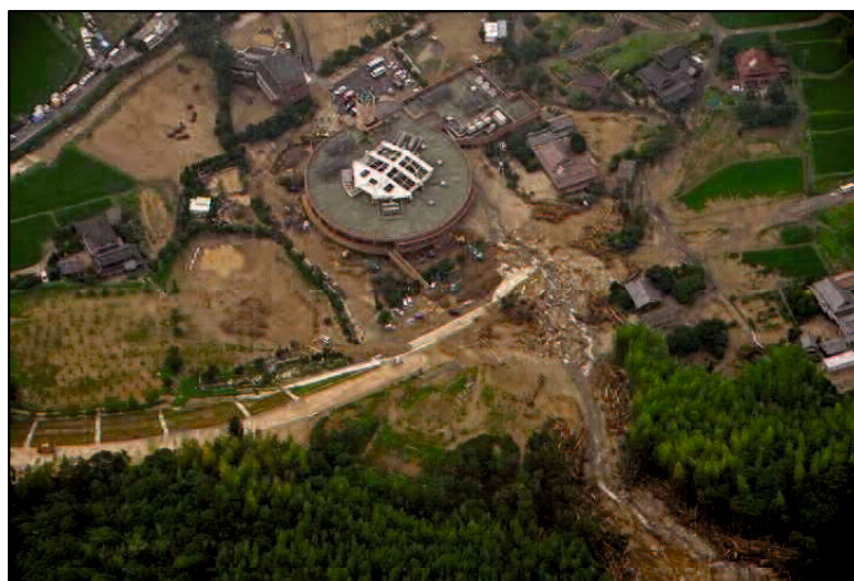
図-2.2 山口県防府市真尾地区で発生した土砂災害の様子 16)
