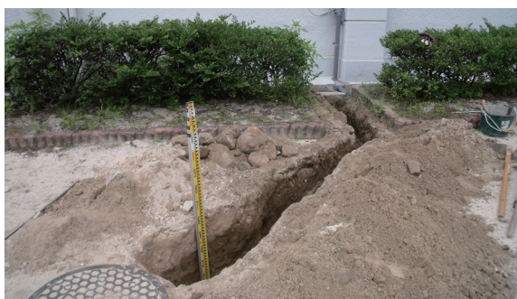
写真 124 掘削地全景 (南東から)
