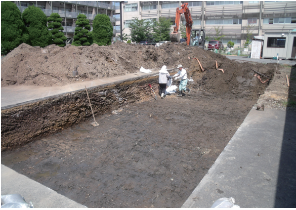
写真 106 重機掘削 (南西から)
