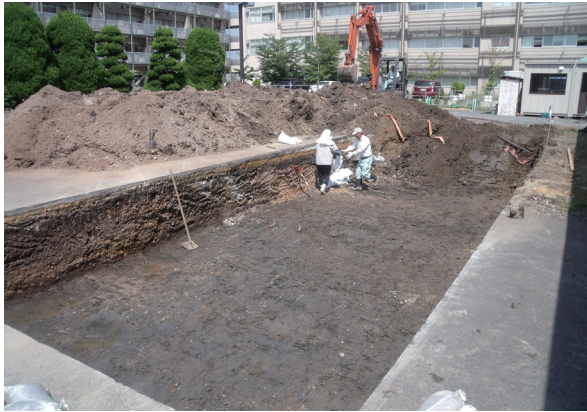
写真 106 重機掘削 (南西から)
