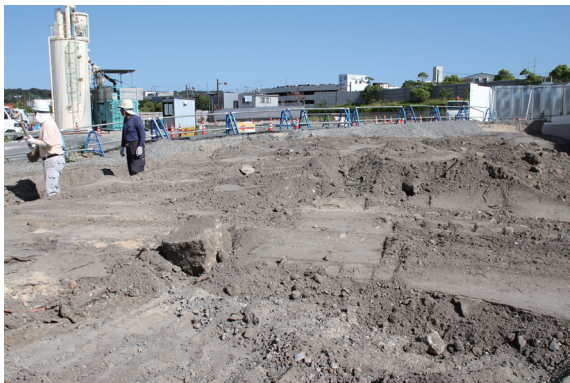
写真 117 工事風景(北西から)
