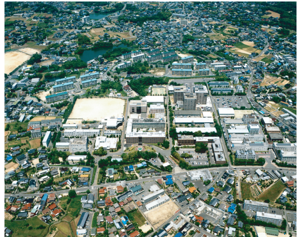
写真30 常盤構内航空写真（南から）
