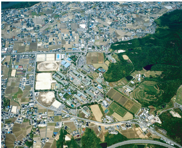
写真26 吉田構内航空写真(南東から)
