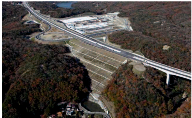
写真-2.3.1 宝塚北 SA 盛土の全景
