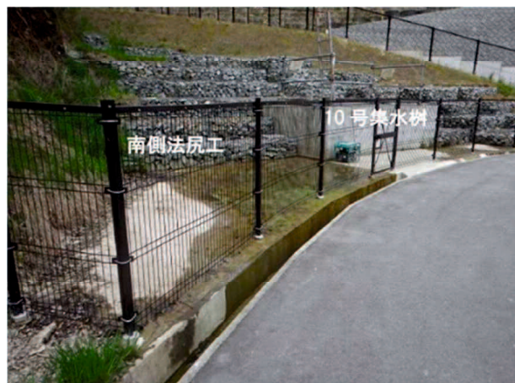
写真-5.4.2 のり尻工からの正常な湧水例
