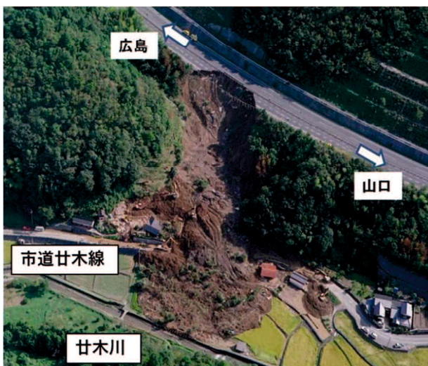
写真-2.2.1 岩国災害被災状況写真
