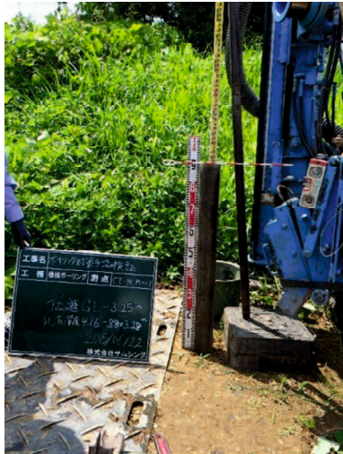
(i) 掘削直後
