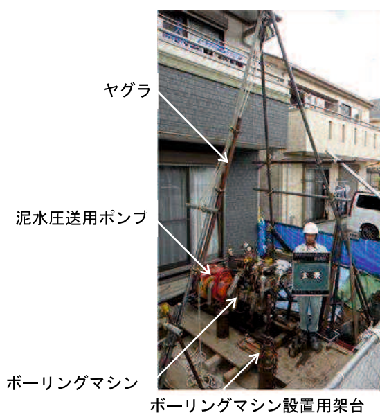
(ii)調査設備の外観
