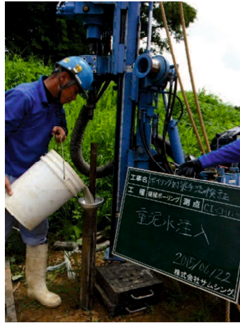
図 3.4-2 ケーシング内への泥水充填状況
