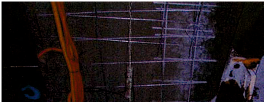
写真 4-3 吹付けコンクリート計の設置状況
