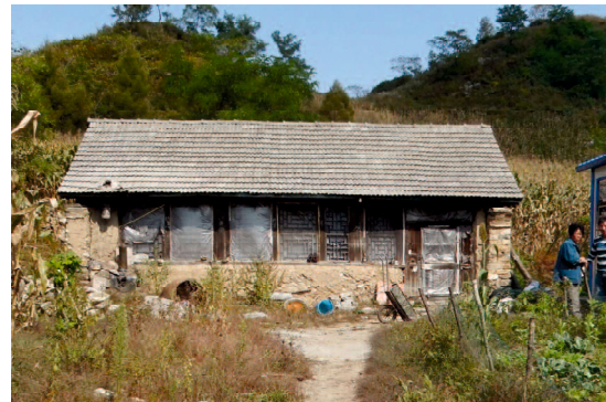
写真 2-3 遼寧省岫岩県呂宅(1906)
