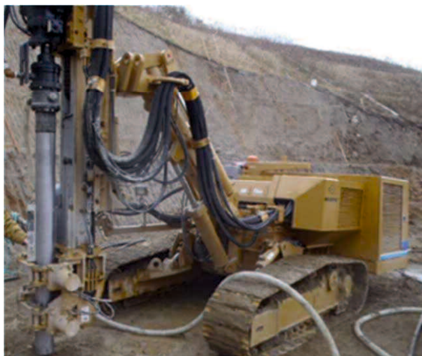
図 3.9 アンカー削孔機据付状況
