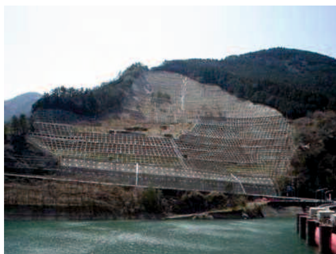
図2.4 大迫ダムのダムサイト左岸部法面に設置したアンカー（農林水産省 近畿農政局 ホームページ）
