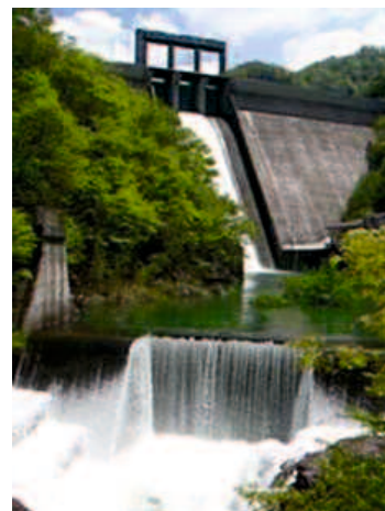
(b) 副ダム（手前）と藤原ダム（北川，2007） 3)
