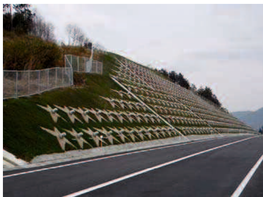
図 2.6 切土に伴う法面崩壊抑止
