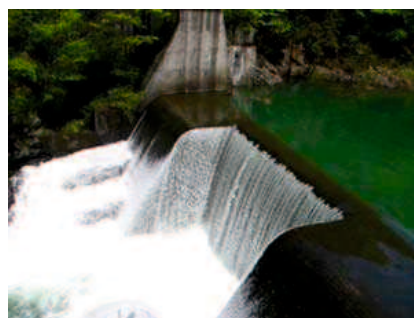
(d) 副ダム（中央12mがP.Sダム）（北川，2007） 3)
