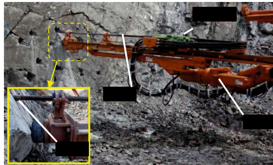
図-3.5 油圧式削岩機の削孔状況
