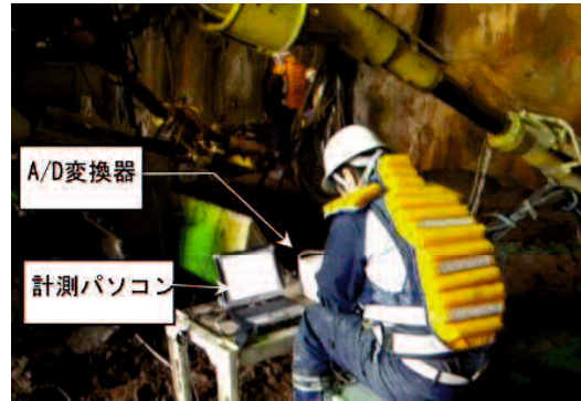
図-3.19 削孔データの計測状況
