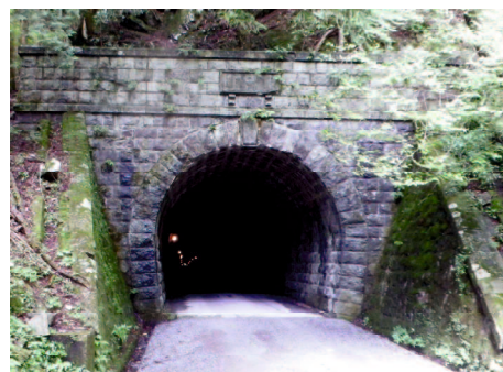
写真-2.1 天城隧道北側坑口 (2015.08撮影)
