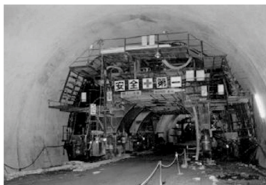
写真-2.3 スライドセントル設置状況 30)
