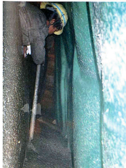
写真-2.4 覆工コンクリート (側壁部)締固め状況 32)
