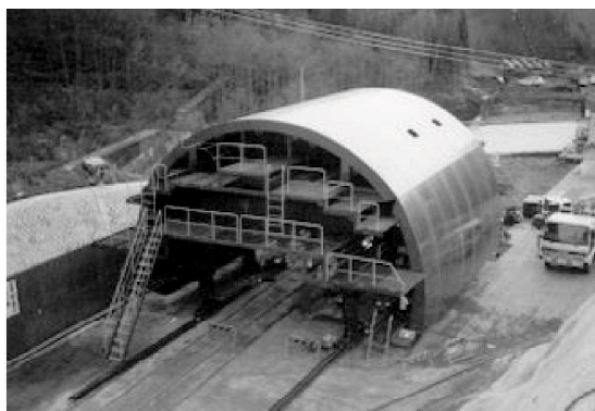
写真-2.2 スライドセントル全景 30)
