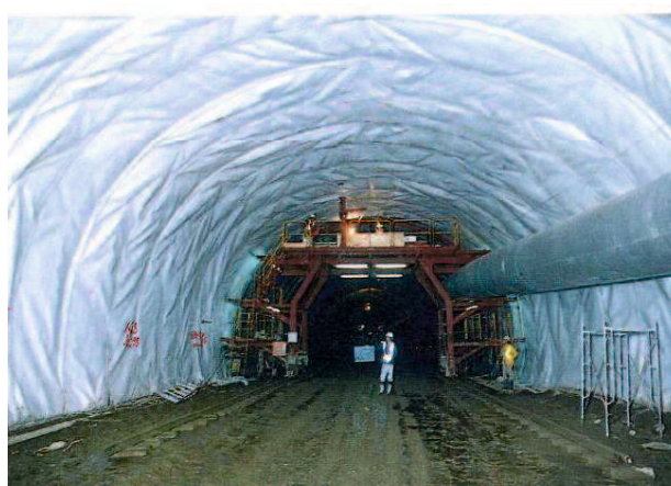
写真-2.5 防水シート展張り完了状況 45)
