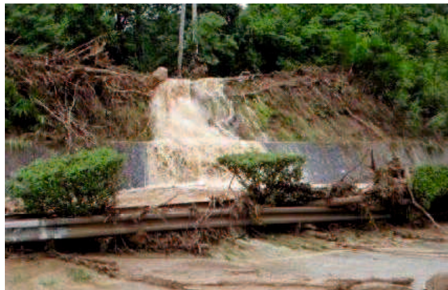
図-3.16 切土のり面での土砂流入災害事例 (H21.7.21 山口インターチェンジ)
