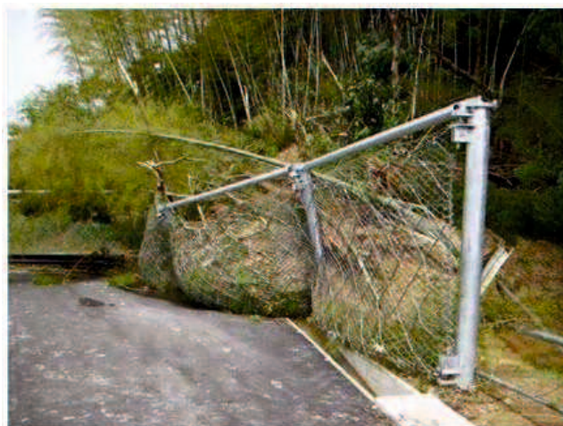
図-3.21 土石流捕捉工（高エネルギー吸収型防護柵）
