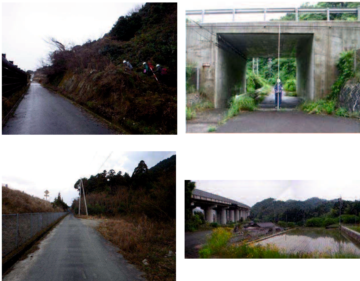
図-3.4 現地詳細調査による高速道路横過条件の確認
