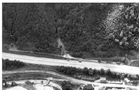
図-1.4 土石流発生状況 (中国自動車道【平成11年】)
