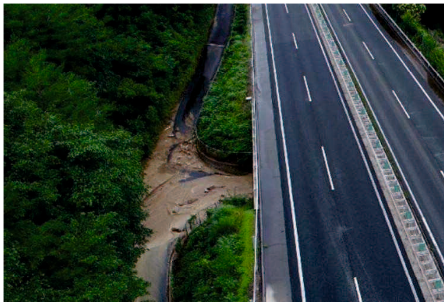
図-3.11 カルバートを流下することで高速道路へ影響が及ばなかった事例 (H30.7月豪雨(山陽自動車道))
