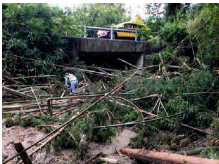
カルバート入口側（谷側）
