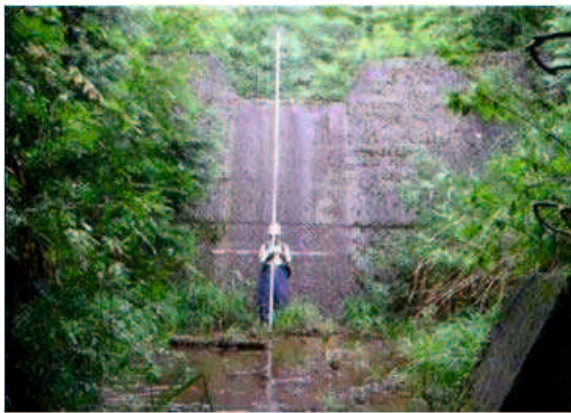
(2) 既存施設調査
