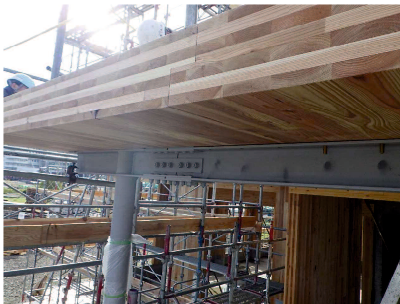
写真 3.2 あいじゃくりのビス接合の施工例
