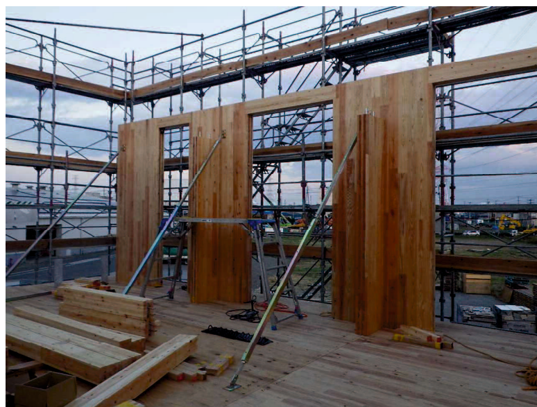
写真 3.1 告示 CLT による床構成
