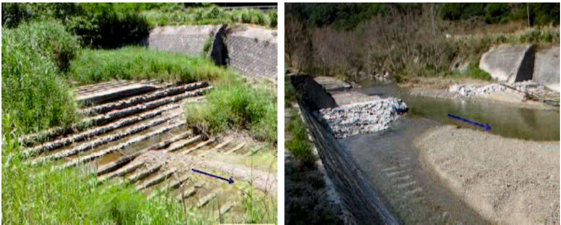
図 4-3 第二落差工撤去前後の状況
