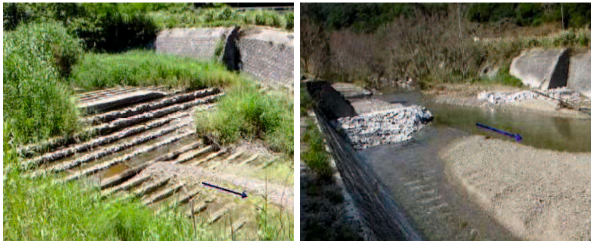
図3-7 奥川事前再生事業における第2 落差工の撤去
