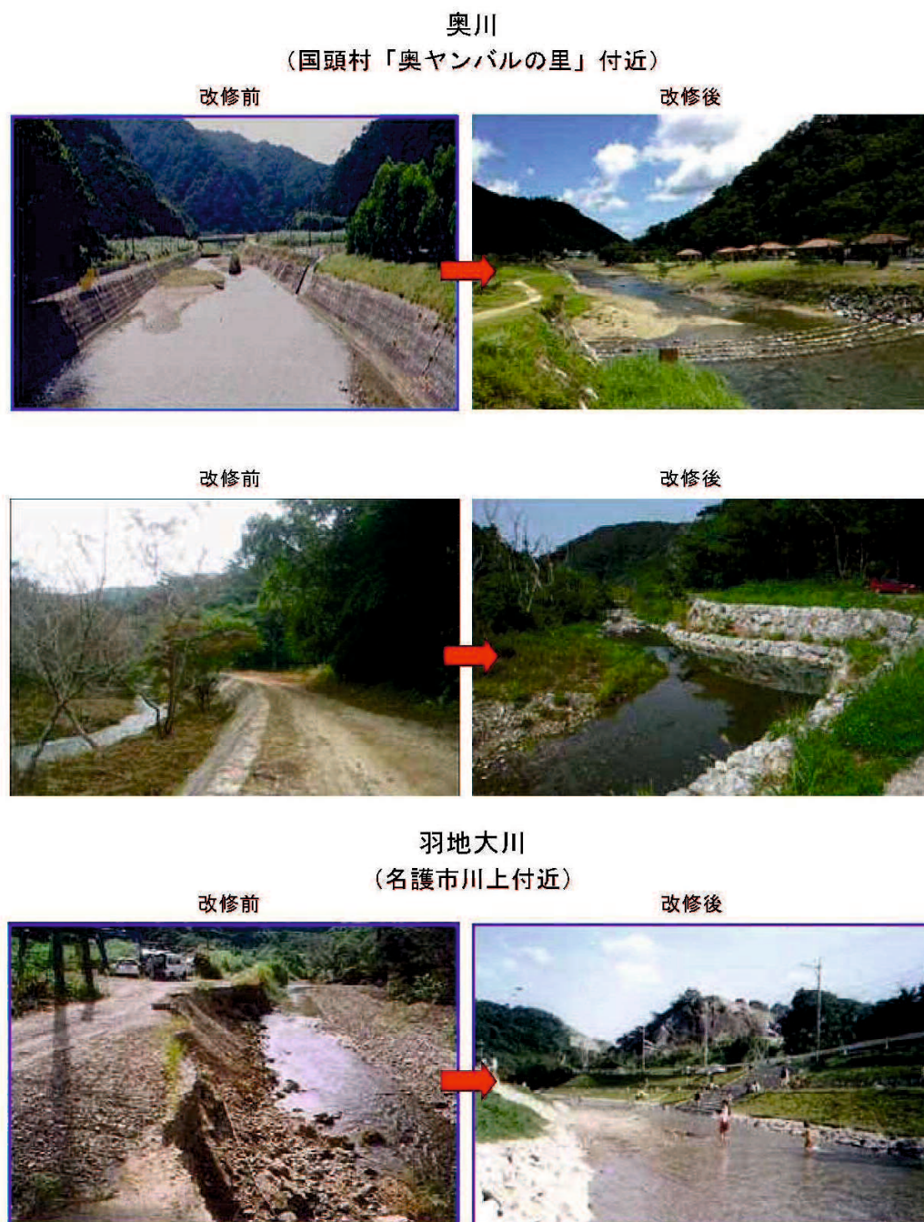
図 2-14(1) 沖縄島における多自然川づくりの一例 14)
