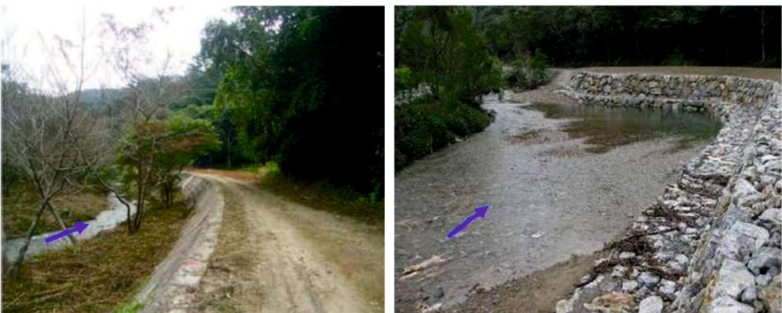
図 4-4 引堤及び水制による淵整備前後の状況
