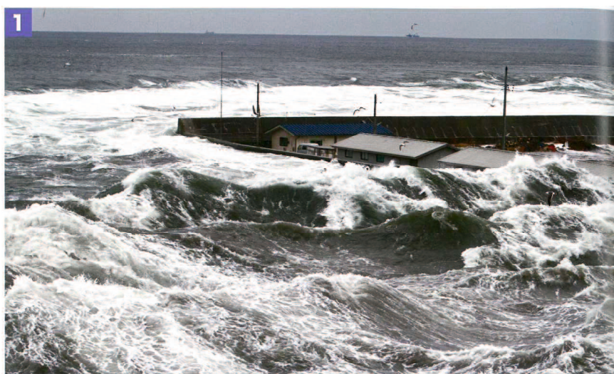
図 2-8. 東日本大震災時に洋野町種市地区を襲った津波第一波 引用：「洋野町東日本大震災大津波の記録」 6)
