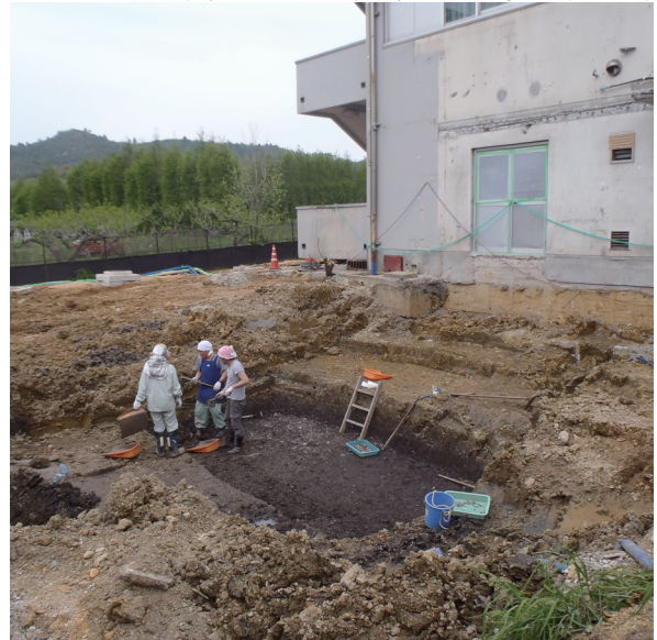
写真 195 平成27年度立会調査区作業着手状況 (南西から)
