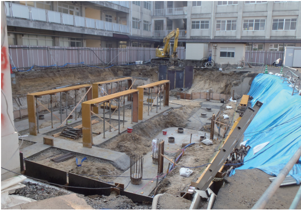
写真175 1地点全景(北から)
