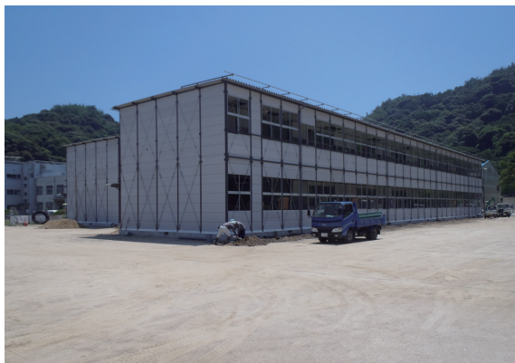
写真 163 仮設校舎(北から)
