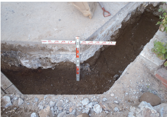
写真179 8地点南東・南西壁土層断面(北東から)
