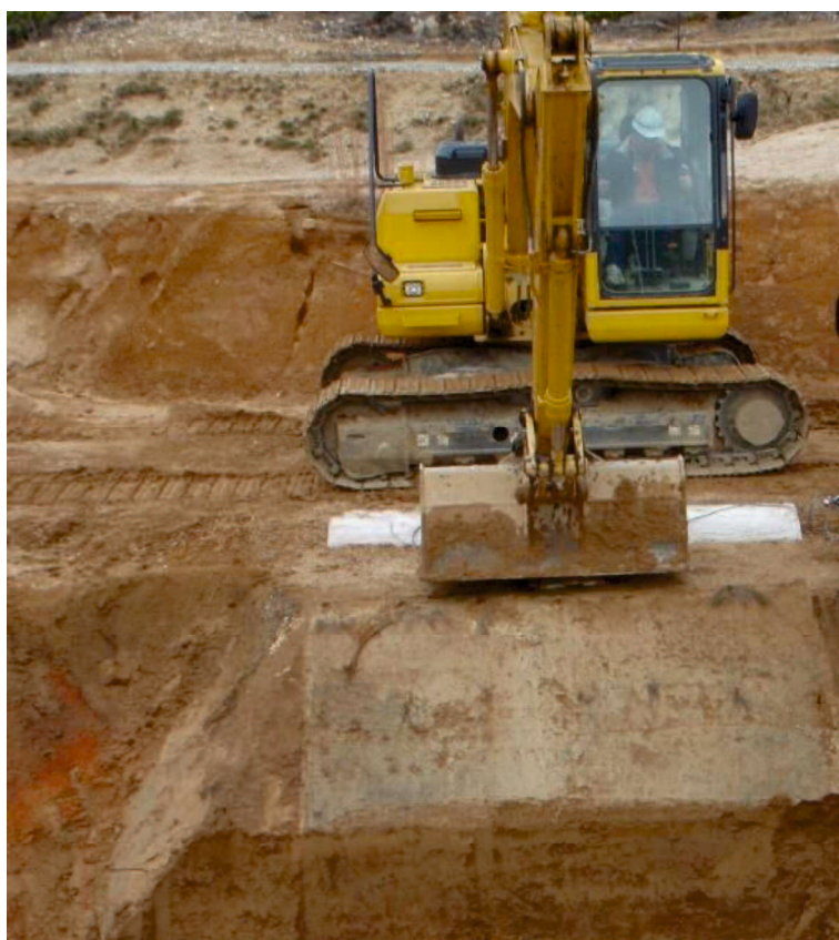
写真-4.6 現場せん断試験状況
