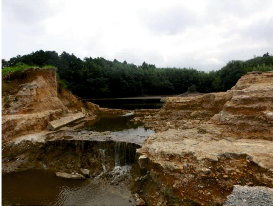
写真-1.1 決壊した火打岩ため池（萩市）
