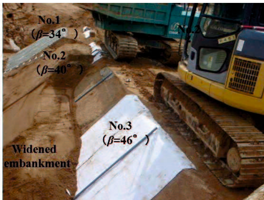
写真-4.2 傾斜角の異なる3ケースの堤体
