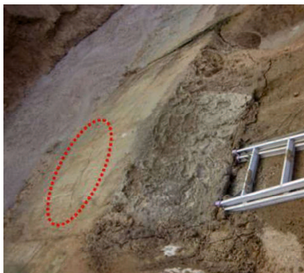
写真-4.4 ベントナイトペーストを塗布した堤体の落水後状況
