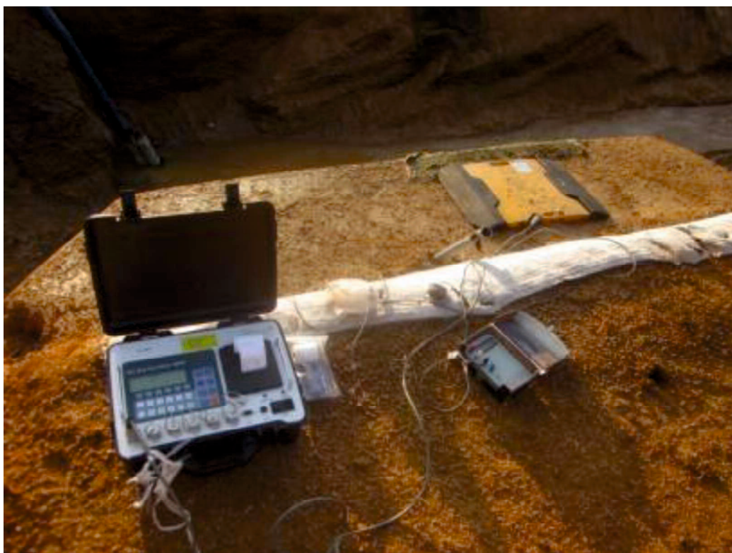
写真-4.5 腹付け盛土の天端に設置した荷重計
