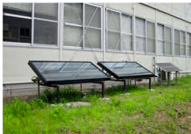
図 4-5 2 段式空気式太陽熱集熱器外観
