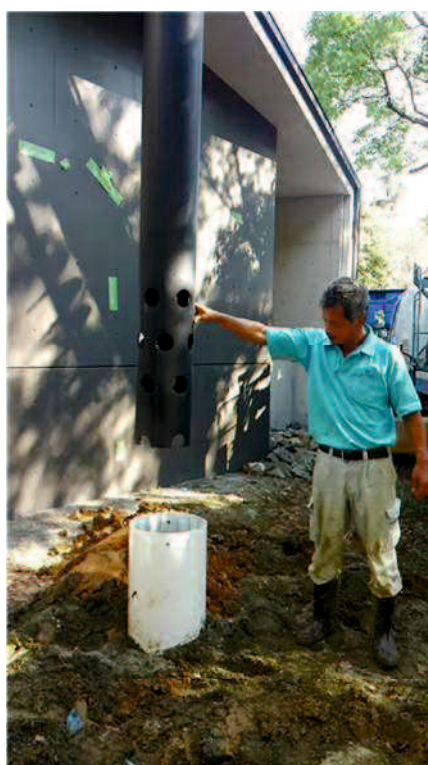
図 5-7 地中熱採熱パイプ埋設状況
