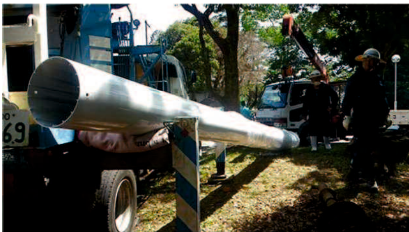
図 5-6 地中熱採熱パイプ外管（アルミパイプ）
