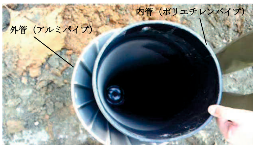
図 5-8 地中熱採熱パイプ設置状況
