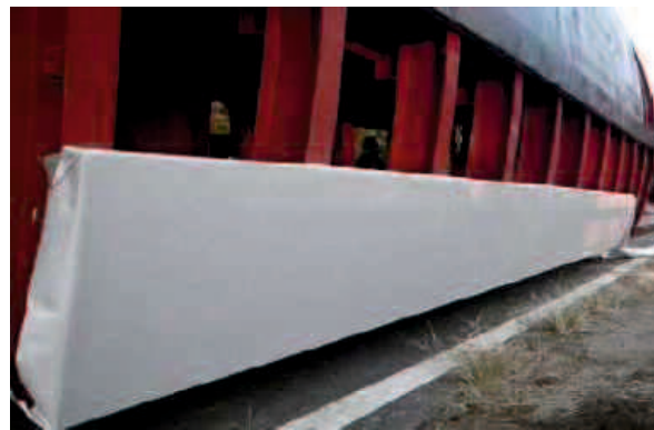
(側壁部への透水シート取付け状況)
