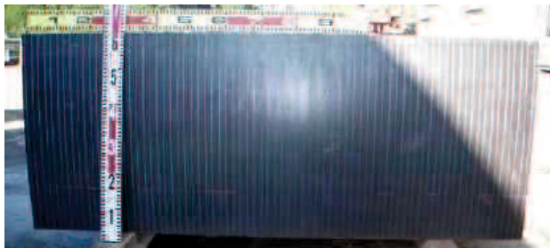
(側壁部の溝入型枠)
