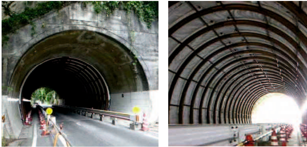
(覆エコンクリート施工前, 鋼製支保工による既設トンネルの断面補強状況)
