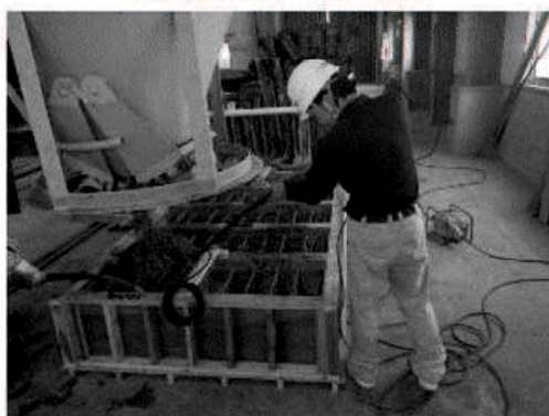
c) コンクリート打設状況
