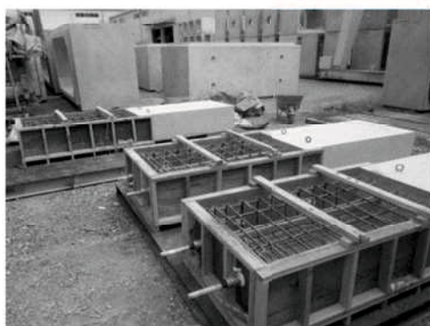
a) 2次ブロック配筋状況
