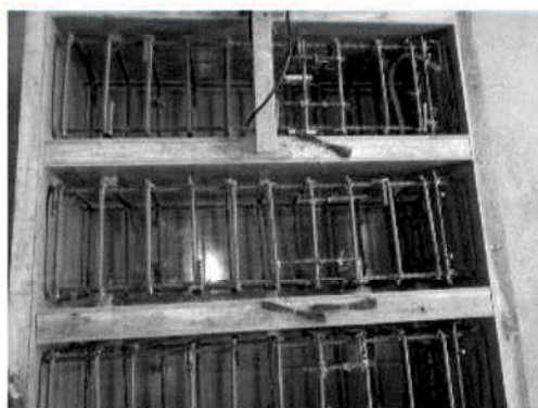
b) 配筋状況
