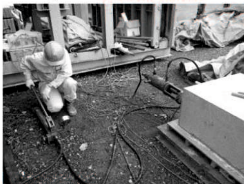
d) ジャッキポンプ操作状況 (PC-1)
