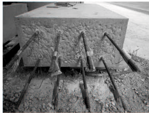
h) 打継ぎ処理状況 (RC)
