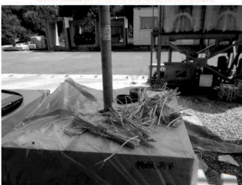
h) PC 鋼棒挿入後状況
