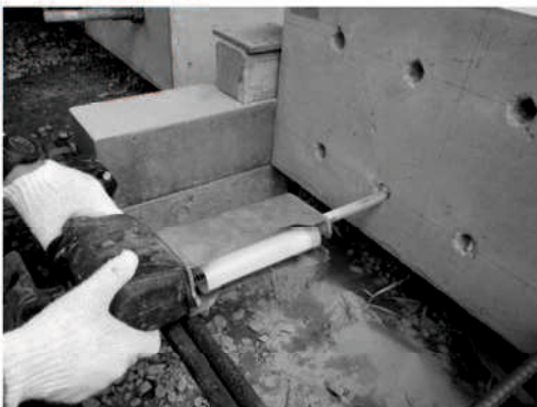
f) あと施工アンカー樹脂充てん状況 (RC)
