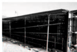
主筋鉄筋・シース組立
