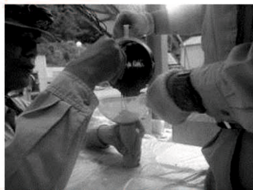
f) 高強度モルタル充てん状況
