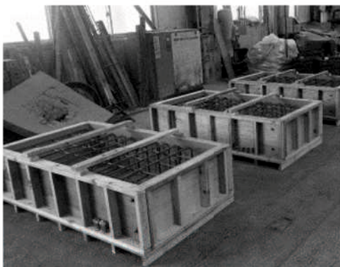
a) 1次ブロック配筋状況
