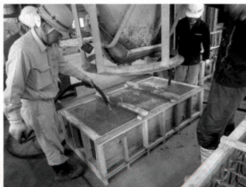
b) 1次ブロック打込み状況
