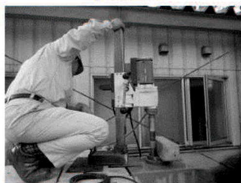
d) コンクリート削孔状況
