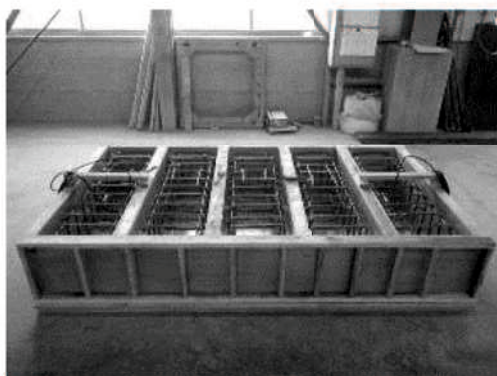
a) 供試体打設前全景
