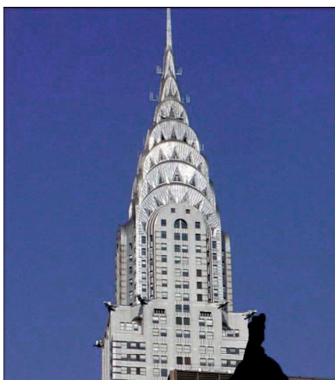
図1-6 アール・デコ建築のクライスラービル
