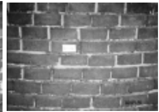
写真2 テーパー部の ボンディングパターン
