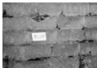
写真8 目地部分に生えた苔 (北側149段目付近)
