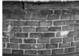
写真1 円筒部の ボンディングパターン
