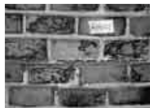
写真7 外表面の付着物 (南西側101段目)
