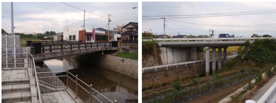
(a) 新権代橋 (1径間橋)
