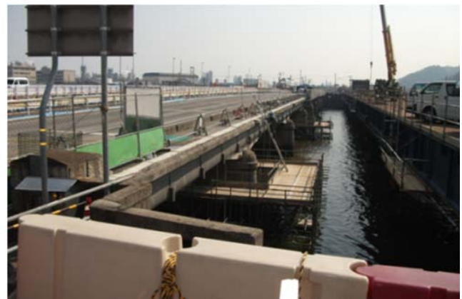
(b) 高欄撤去後
