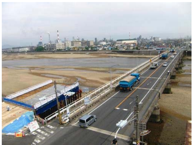
図-28 対象橋梁(栄橋)の供用中の概観写真
