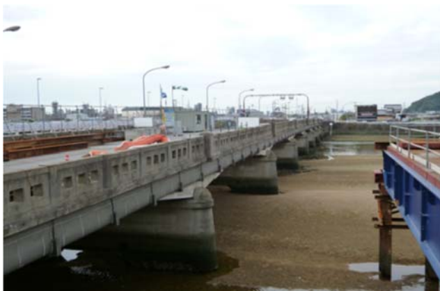
(a) 高欄撤去前
