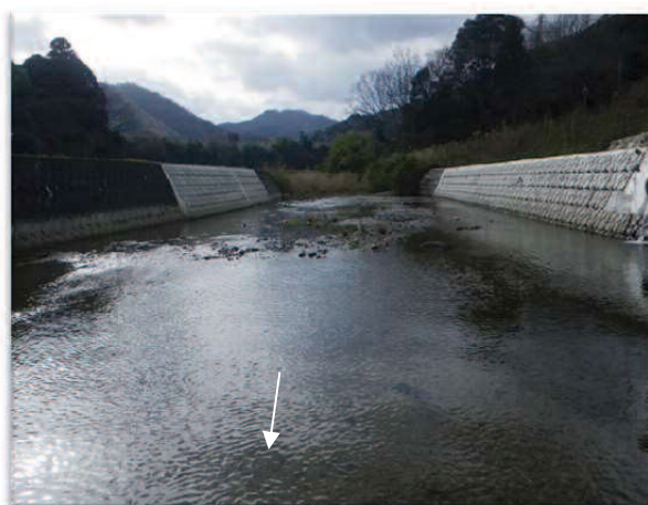
BP (施工済み横断箇所)
