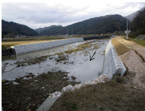
阿武川 川幅約 30m (施工済)
