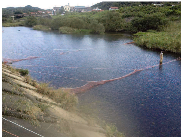
写真-2 仕切り網の設置状況
