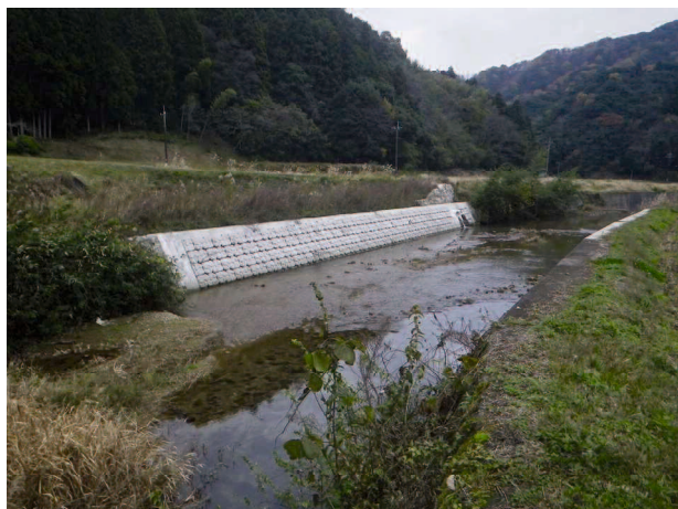
全景 (平成27年12月) 施工2年後
