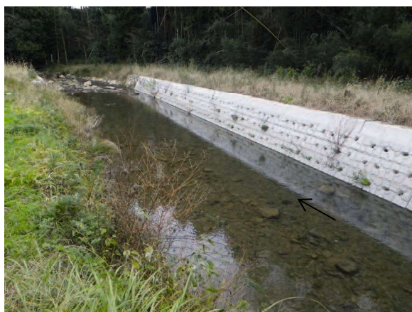
田万川 川幅約 15m (右岸施工済)
