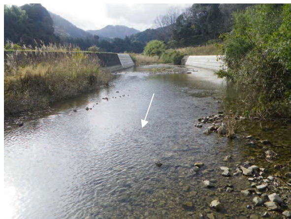
BP-10.5 (未施工横断箇所)
