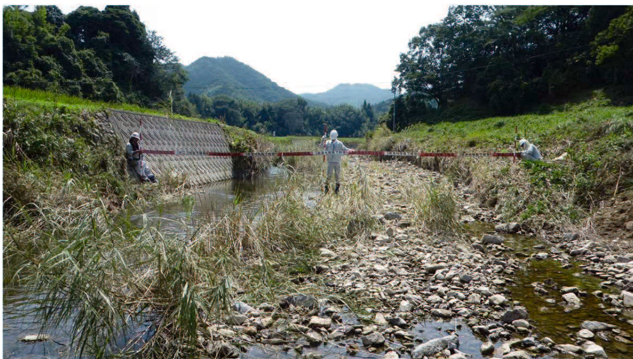
写真-8 横断写真 (+33.0) 平成25年
