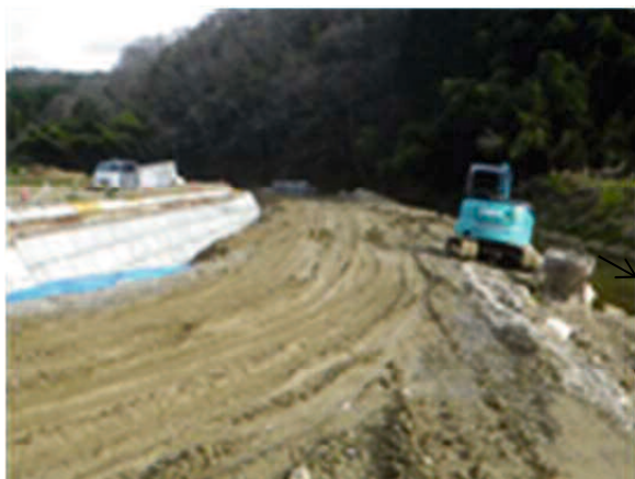
阿武川工事中（河床内工事用道路）
