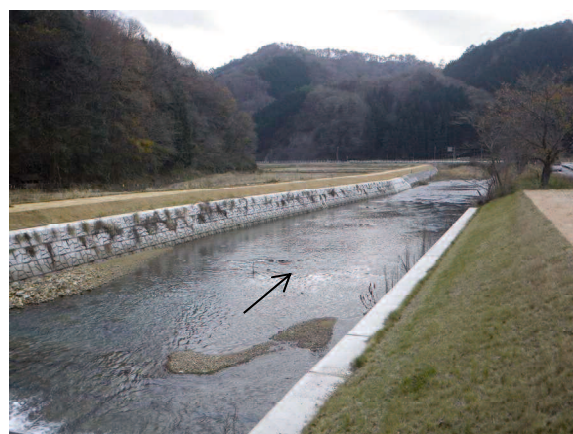
阿武川 川幅約 30m（施工済）
