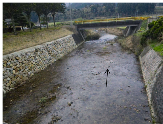
田万川 川幅約 15m (両岸施工済)
