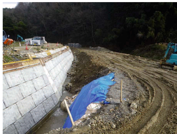
阿武川工事中（床掘）
