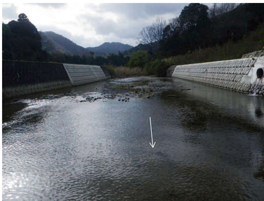
写真-10 工事2年後でも河床はフラットな状態 (川幅約15m)
