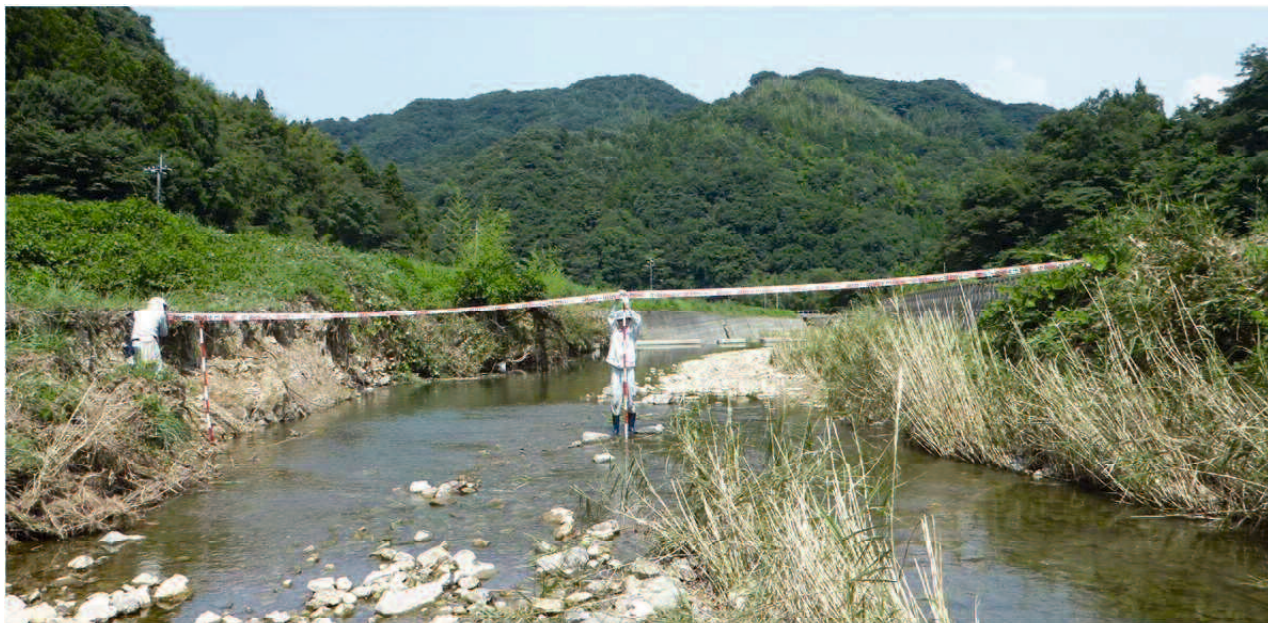
写真-7 横断写真 (+15.0) 平成25年
