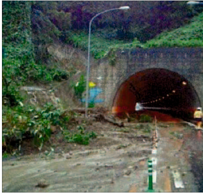
図-5.25 No.5 米子自動車道 蒜山 IC ～江府 IC 自然斜面(土石流)災害
