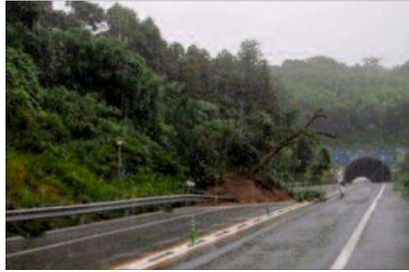
図-5.26 No.11 江津道路 江津西 IC～浜田東 IC 自然斜面災害
