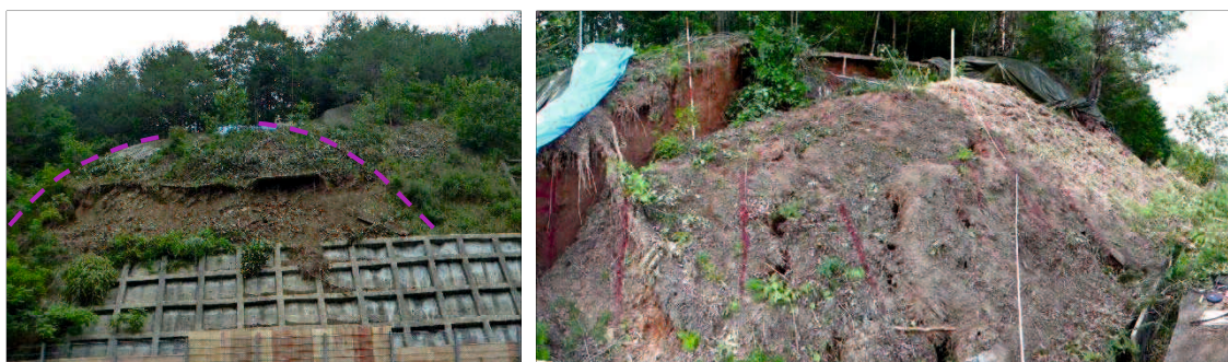
図-5.24 No.2 岡山自動車道 有漢 IC～北房 JCT 切土のり面災害
