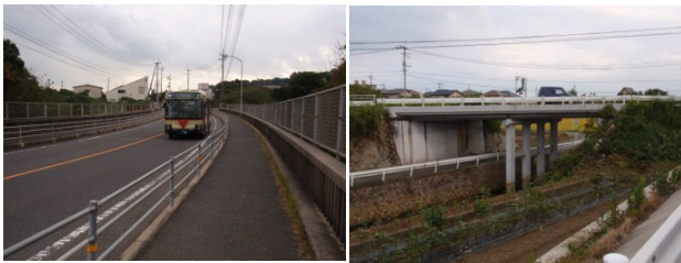
(a) 蛇瀬橋 (5径間) (b) 白土第二橋 (2径間)
