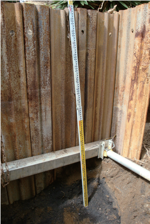
写真205 No.8北西壁土層断面(南から)
