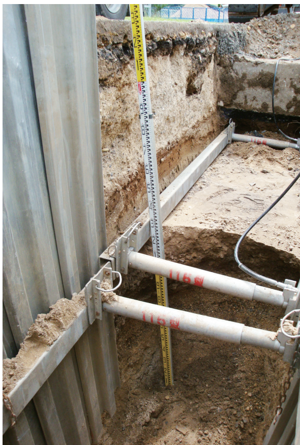
写真186 15地点北東壁・南東壁土層断面(西から)
