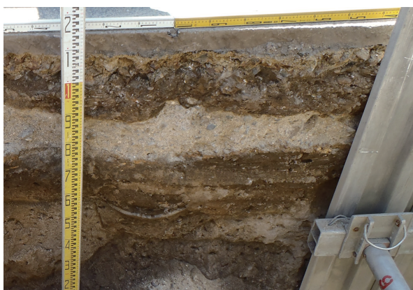
写真178 7-1地点(No.2より4.5m南東)南西壁土層 断面(北東から)
