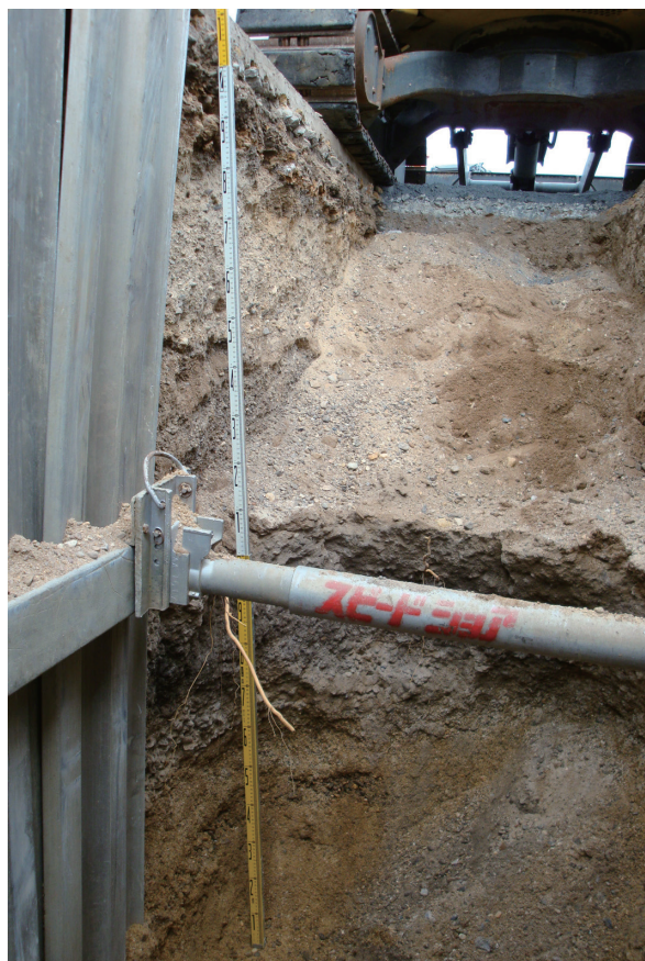
写真187 16地点北東壁・南東壁土層断面(西から)
