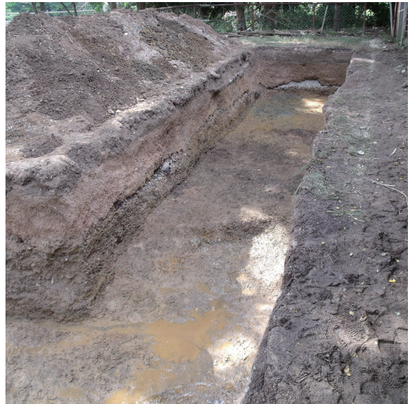
写真 16 南北トレンチ完掘状況 (南から)
