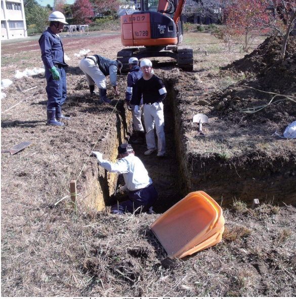
写真 66 調査風景 (西から)
