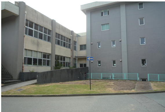
写真 20 調査前全景(東から)
