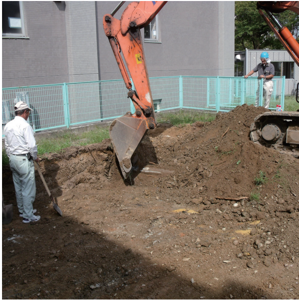
写真 23 重機掘削風景 (南東から)
