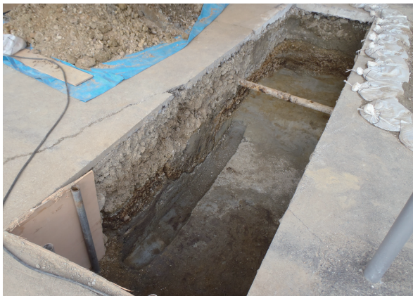
写真84 D調査区全景(南から)
