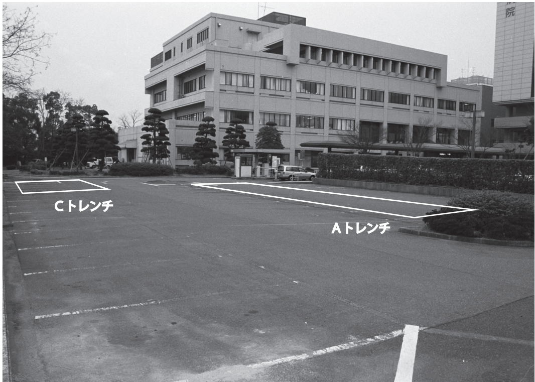
(1) 調査区近景（北東から）
