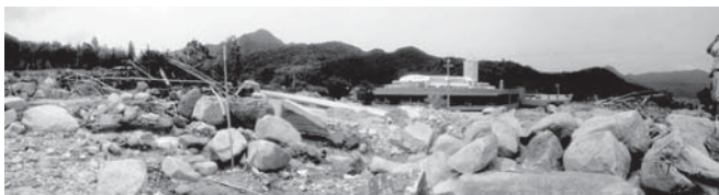
(b) 老人ホームの裏側の土石流の堆積状況 写真-4 真尾地区の土石流と特別養護老人ホームの被災状況
