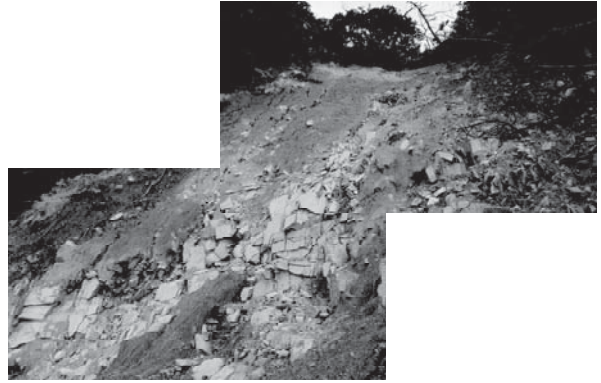
写真-6 勝坂周辺の土石流の主要源頭となった崩壊部
