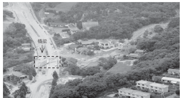
写真-2 勝坂付近の土石流（写真中央の橋梁が損壊）
