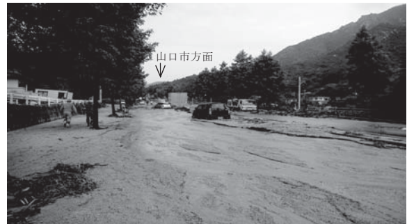
写真-1 国道262号の被災状況
