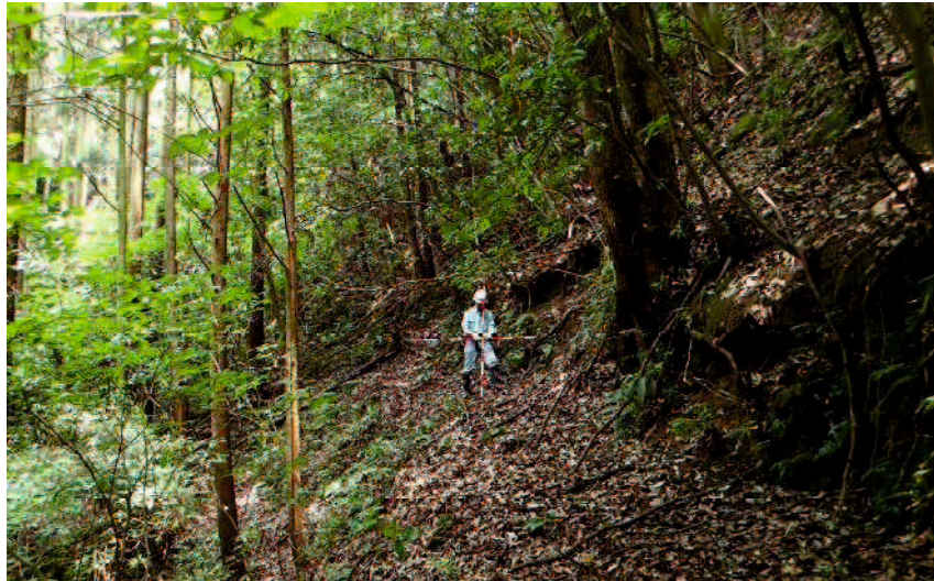
写真-4.4 斜面の崩壊状況
