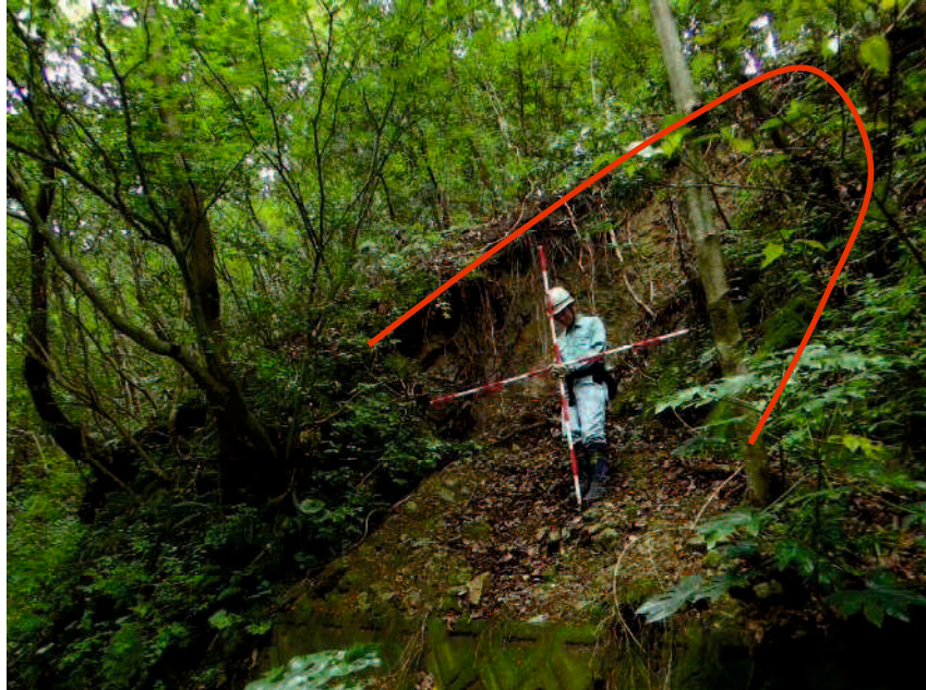
写真-4.3 斜面の崩壊状況
