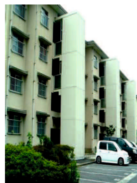
写真2 各階段室に設置したエレベーター
