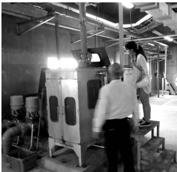
図 6-2:福岡市の集落排水施設の調査
