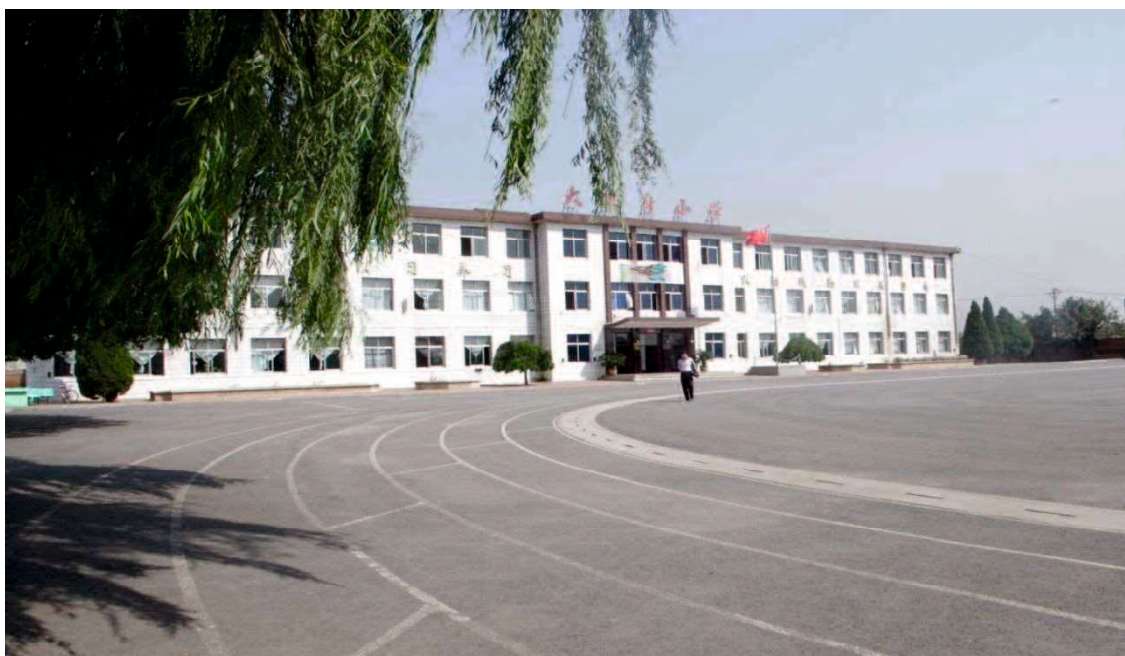
図4-1 D小学校の校舎
