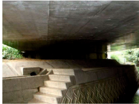
写真 5.3.7 SKT 橋の桁下写真
