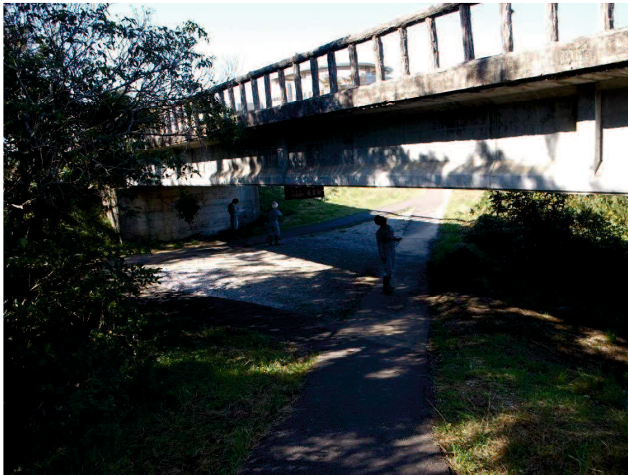
写真 5.3.8 目視点検状況
