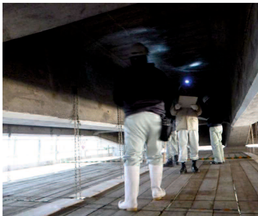
写真 4.3.3 変状調査状況
