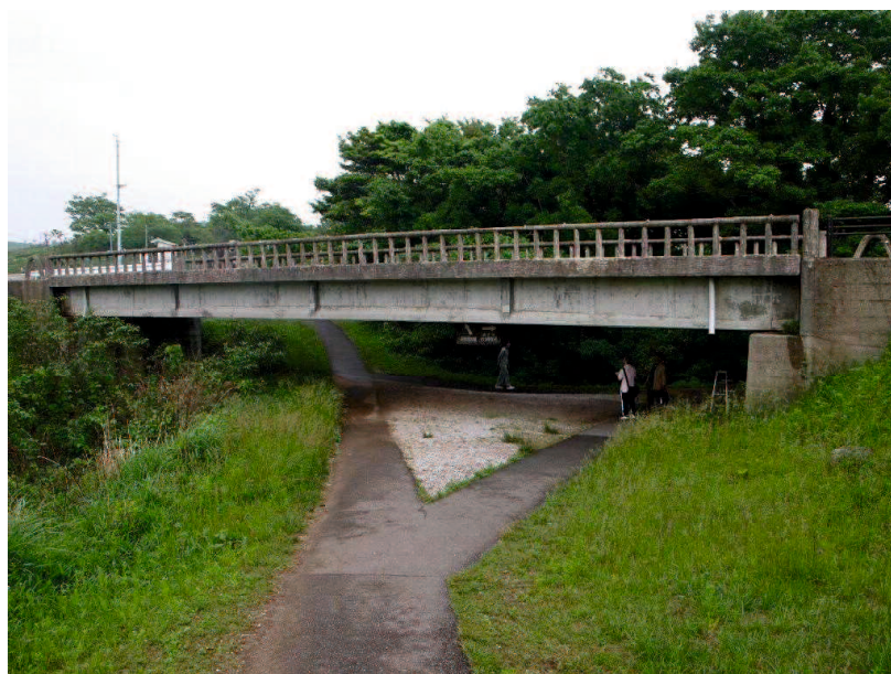
写真 5.3.1 MH 橋の現況写真（2011 年現在）
