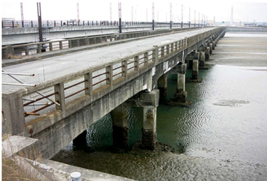
写真 4.3.1 旧 KT 橋の撤去前状況
