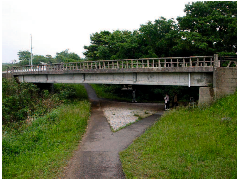
写真 5.4.1 MH 橋の現況写真（2011 年現在）
