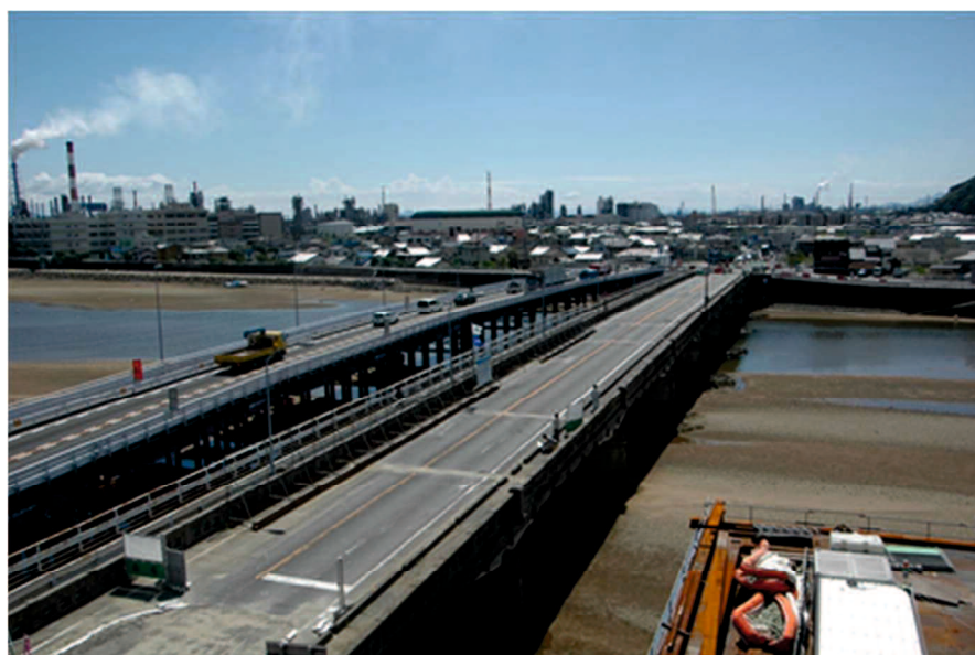
写真 4.3.2 旧 SK 橋の撤去前状況
