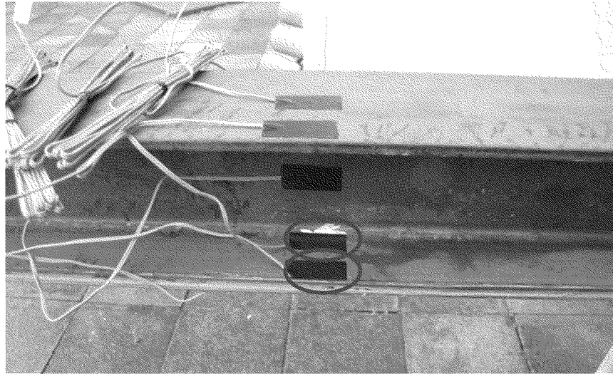
写真-4.3 支間中央部ひずみゲージ貼り付け位置（暴露期間 168 日における曲げ載荷試験）
