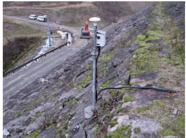
写真-5.2 ダム下流面ロック部に設置した GPS センサー
