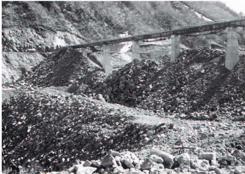
写真-5.3 投石工法による盛立工事中の石淵ダム 9)
